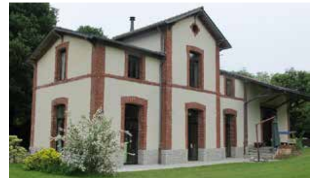
Figure 24 La mobilisation du patrimoine bâti : une des réponses au besoin de production de logements ou d'équipements sans consommer de foncier agricole
