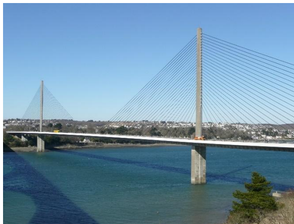
Figure 52 : Pont de l'Iroise, Plougastel (crédits : ADEUPa)
