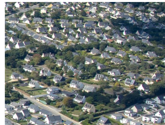
Figure 53 : Développement pavillonnaire à Guilers (crédits : ADEUPa)
