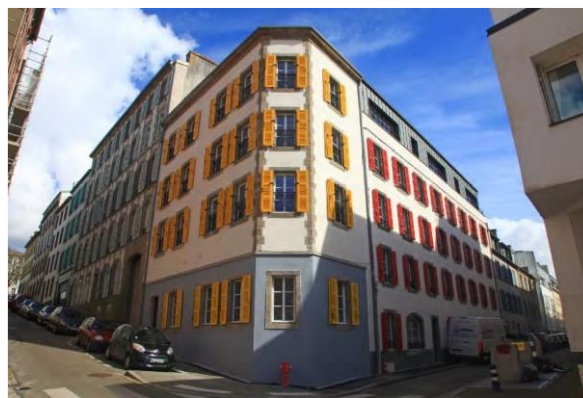
Figure 57 : Réhabilitation de logements à Recouvrance (crédits : ADEUPa)
