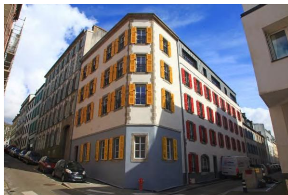
Figure 57 : Réhabilitation de logements à Recouvance (crédits : ADEUPa)
