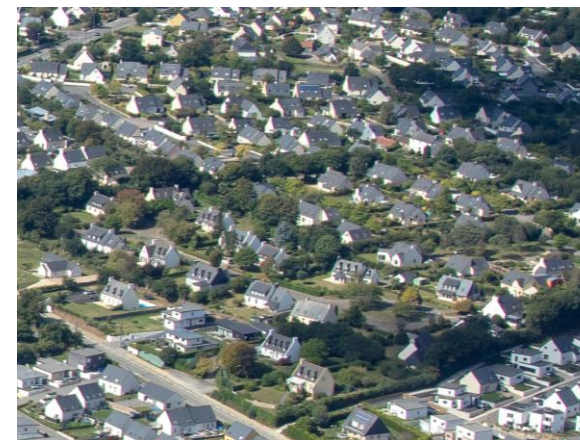
Figure 53 : Développement pavillonnaire à Guilers (crédits : ADEUPa)
