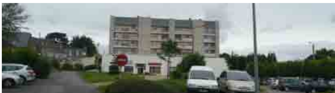
Exemple 2 - Collectif isolé à Lesneven
