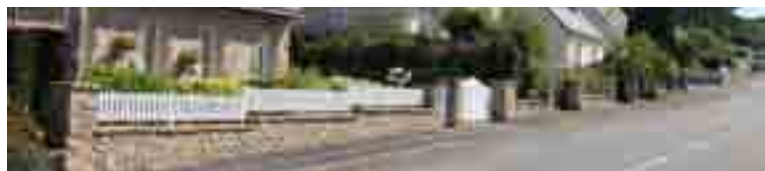
Exemples de clôture
