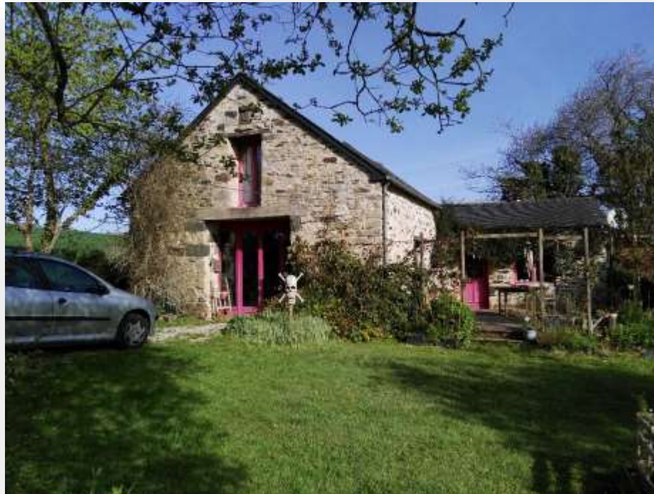
Ancienne grange transformée en habitation – lieu-dit Keranroy, commune d’Hanvec
