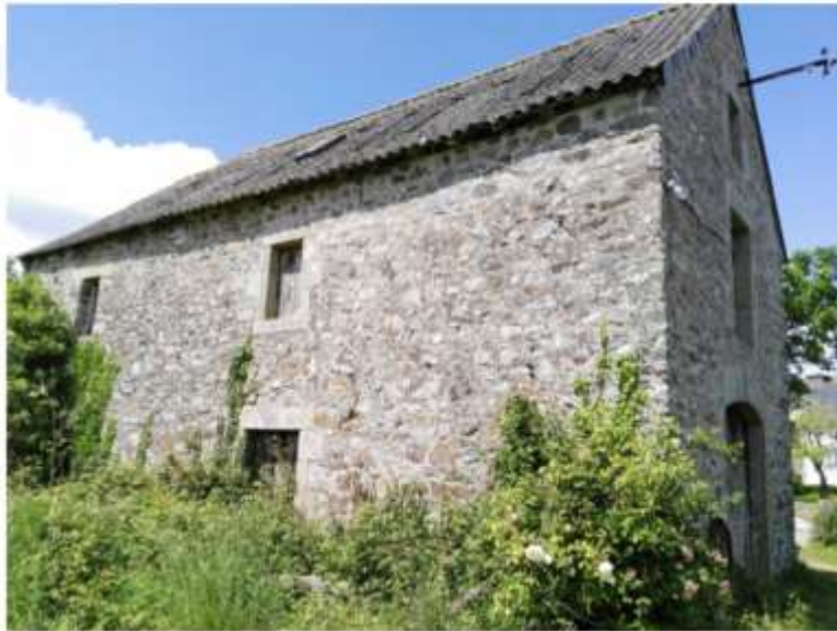
Bâtiment 7 - Grange - étable
