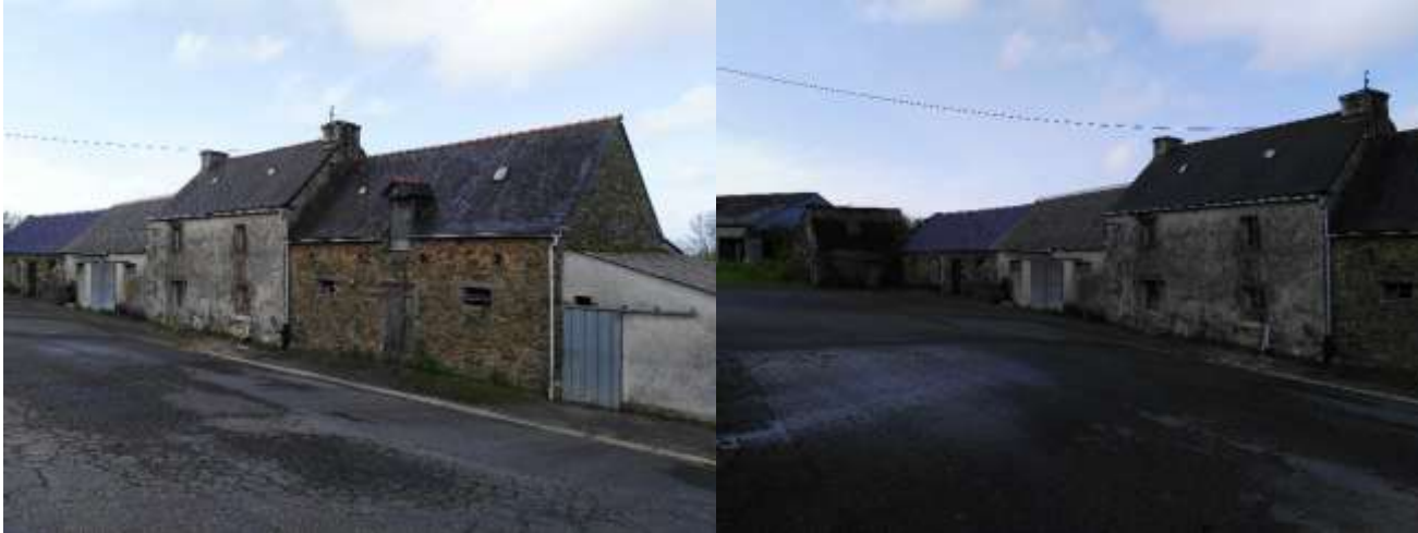
Bâtiment 2 - Corps de ferme linéaire
