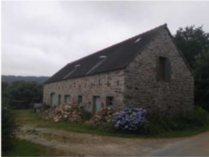
Bâtiment 1 - Grange étable
