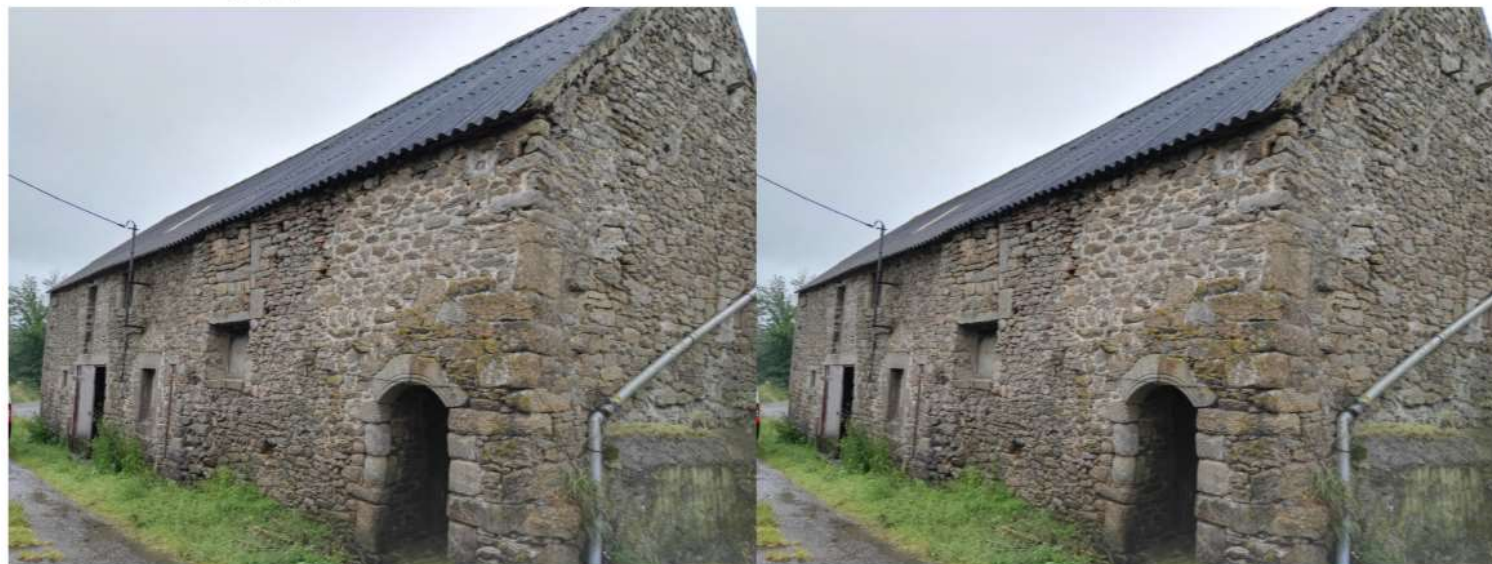
Bâtiment 5 - Ancien logis paysan
