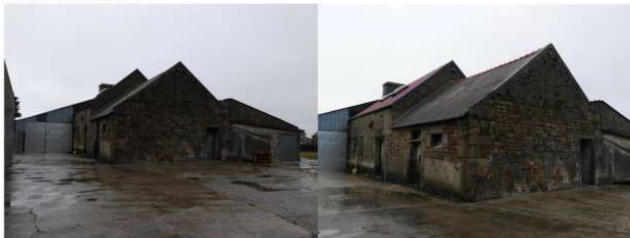
Bâtiment 3 - Ancien logis paysan
