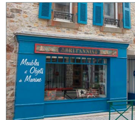
Grâce au bois, cette vitrine retrouve un habillage. La couleur est harmonisée avec les volets de l'étage.
