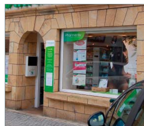
Cette maçonnerie en pierres de taille de Logonna, avec sa porte cintrée, est un élément important à préserver.
