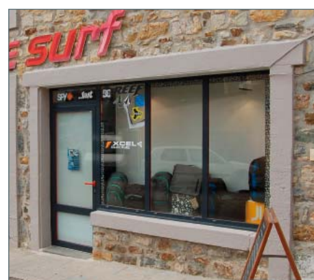
Les châssis de teinte foncée permettent de créer un cadre sans rajouter de couleur supplémentaire.
